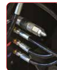
Prueba de presión de nitrógeno
