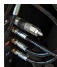
Prueba de presión de nitrógeno
