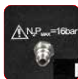
Test szczelności z azotem
