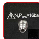
Test szczelności z azotem
